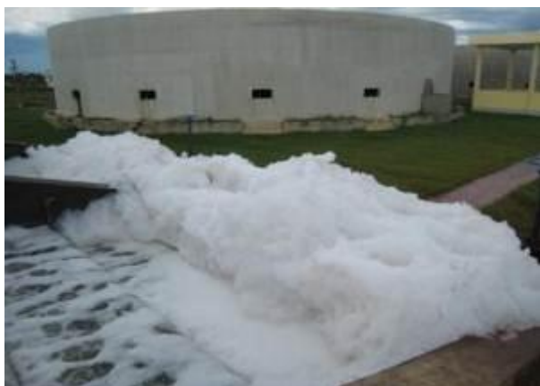
Dự án xử lý nước thải Quy Nhơn
